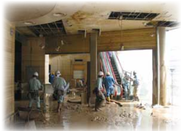
福井豪雨時の福井商工会議所ビルの復旧作業風景 提供：福井商工会議所ビル
